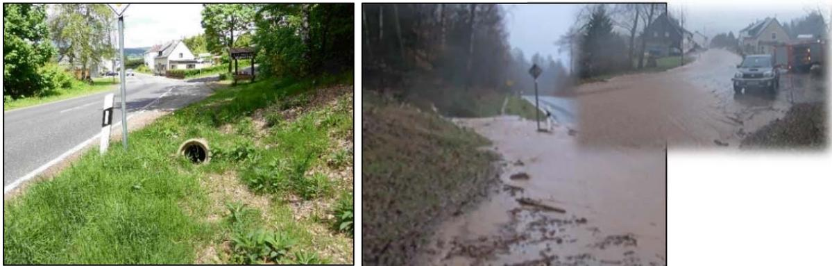
Abb. 2: Bild links: Einlauf Straßendurchlass im Bereich der Saarstraße am Ortseingang von Neuhütten; Bilder rechts: Überschwemmungen im Bereich der Saarstraße (Quelle: SWR.de).
