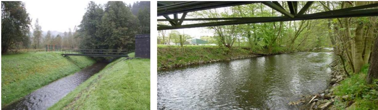
Abb. 1: Messstellen unterschiedlicher Charakteristika (links Pegel Neumühle: ausgebautes Profil mit befestigter Sohle, rechts Pegel Hummelsheim: begradigtes Gewässer, jedoch mit Geschiebetrieb).
